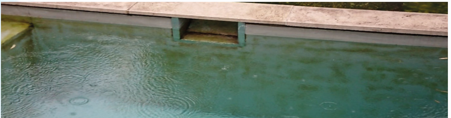
Glitschige Beläge an der Beckenwand
