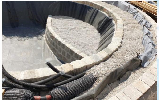
Hydrobalance Filter / erdmodellierter Naturpool
